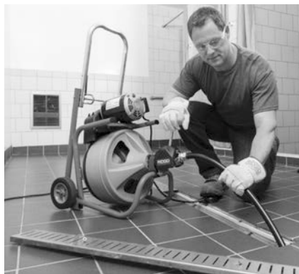
Рис. 16 – Использование машины с направляющим шлангом
